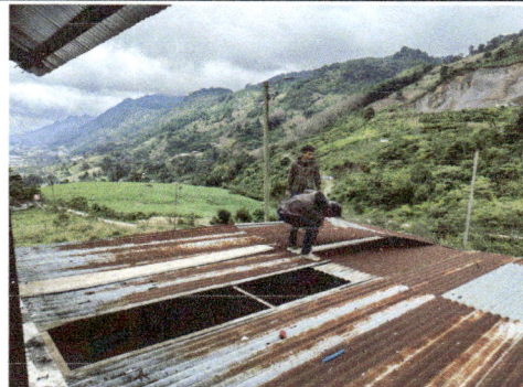
Foto 2: Desentechado. Momento en que se inició a quitar las láminas oxidadas y deterioradas.
