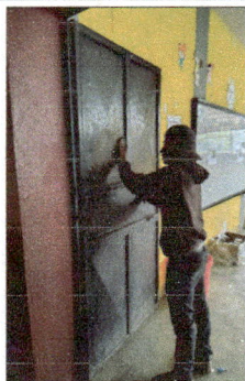
Foto 1: Lijada de las puertas. Se hizo limpieza y lijado de las puertas antes de la pintura y el cambio de algunas chapas.
