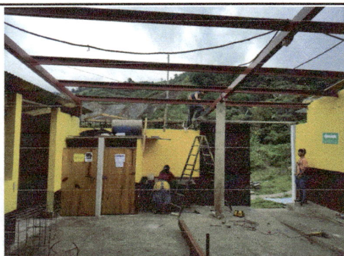
Foto 3: Instalación de estructura metálica.
