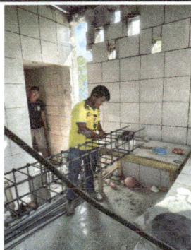
Foto 5: Preparación de las columnas para reforzamiento de las paredes de la cocina.
