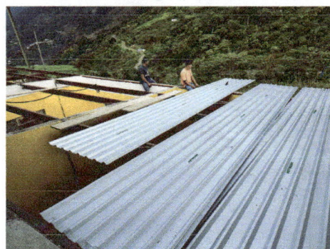
Foto 4: Colocación de las láminas nuevas al entechado.
