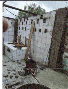
Foto 6: Fundición de una parte del piso de la cocina.
